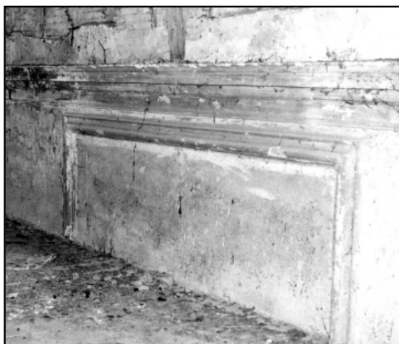
Il soffitto a volto del salone di rappresentanza situato al primo piano del palazzo Bettini nel secolo scorso fu demolito e il grande vano così ottenuto fu tagliato con un nuovo solaio per raddoppiare lo spazio utilizzabile. La foto mostra alcuni resti dei riquadri in stucco che ornavano il salone, entro i quali in origine erano posti grandi quadri in tela. Sopra tali riquadri si possono notare le cornici modanate che segnavano l'inizio del soffitto a volto.
