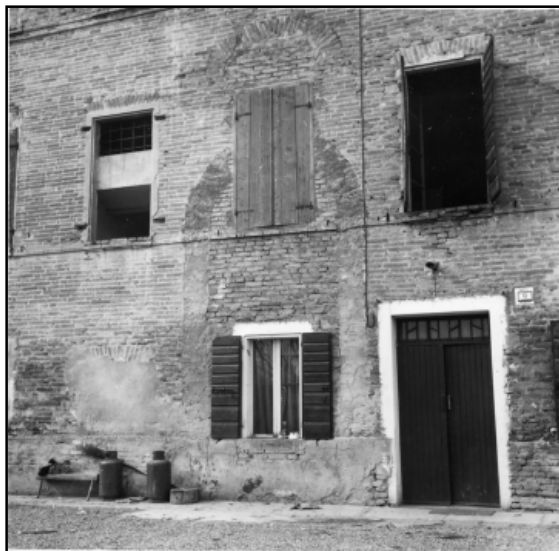
Particolare della facciata sud-est del palazzo, in cui si notano i segni del grande portale d'ingresso al piano nobile e del sovrastante finestrino ovale, entrambi tamponati.
