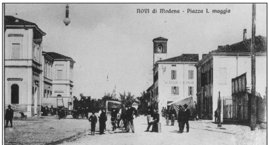
Novi dopo l'abbattimento del Palazzone
